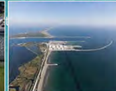
Compuertas contra marejadas Malamocco, Venice, Italy
