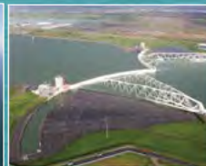
Rào chắn sóng trào trong bão, Maeslantkering, Hà Lan
